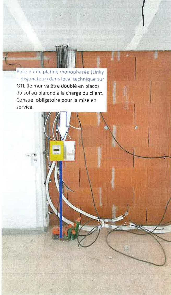
Pose d'une platine monophasée (Linky + disjoncteur) dans local technique sur GTL (le mur va être doublé en placo) du sol au plafond à la charge du client. Consuel obligatoire pour la mise en service.
