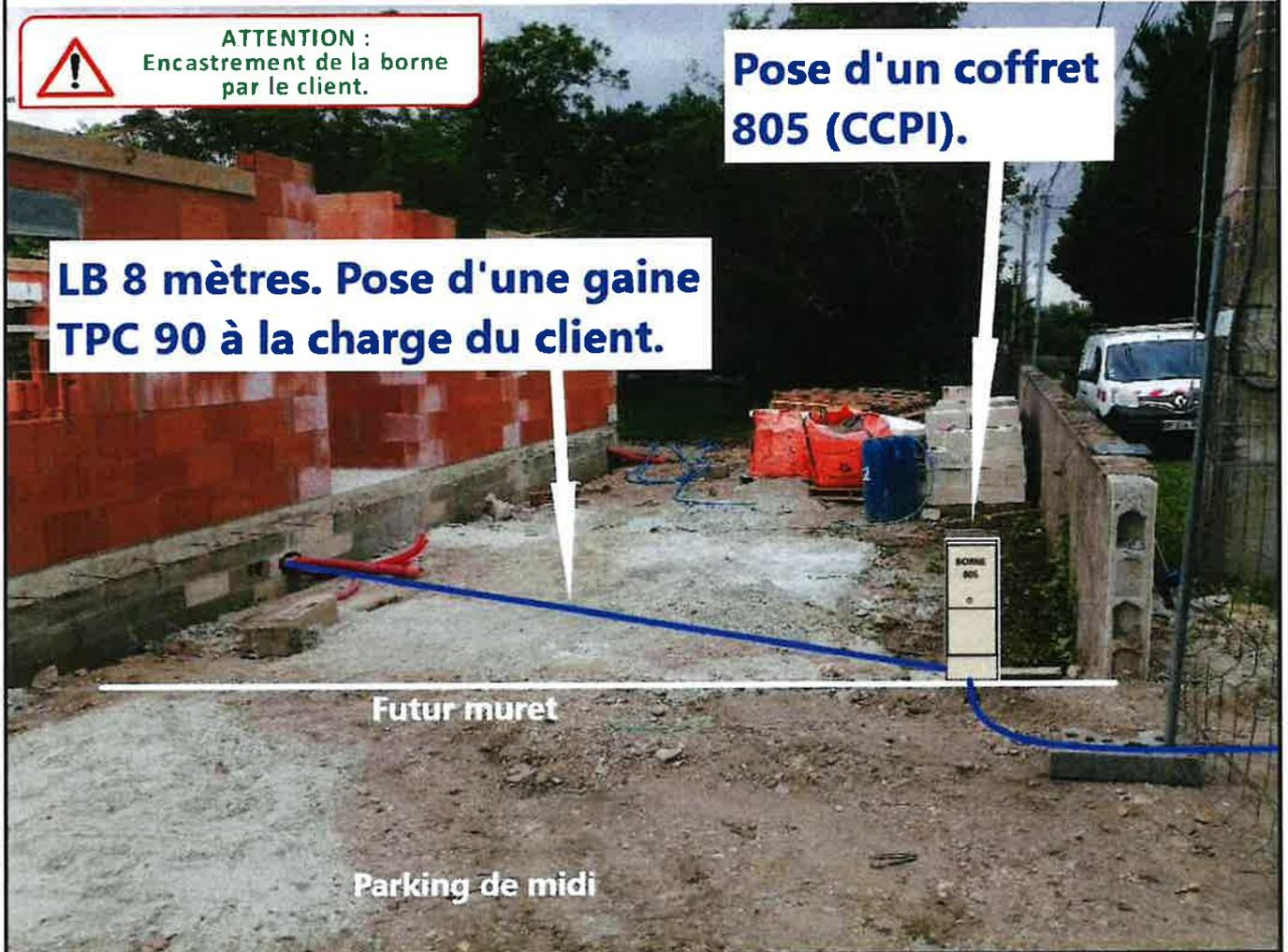
**Pose d'une platine monophasé (Linky + disjoncteur) sur GTL avec séparation à la charge du client. Consuel obligatoire pour la mise en service.**
