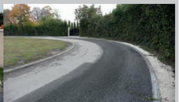
Rue de la Gare (calibrage de la voie dans le virage et creation de bord)
