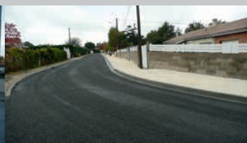
Rue du Basque (depuis l'autoroute bis)
