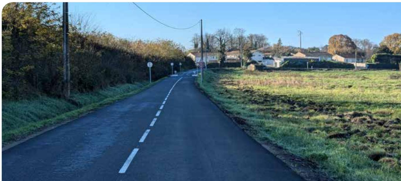
**Fin juillet 2024**, c'est 1,4 km de voirie qui a été refait. Il s'agit du tablier routier (divers revêtements ont été utilisés : enrobés et bicouche gravillonné selon le trafic) et du système de recueillement des eaux pluviales avec les bordures et les bouches avaloirs pour capter ces eaux. Une sécurisation par des écluses a également été réalisée afin de réduire la vitesse à 30km/h.
