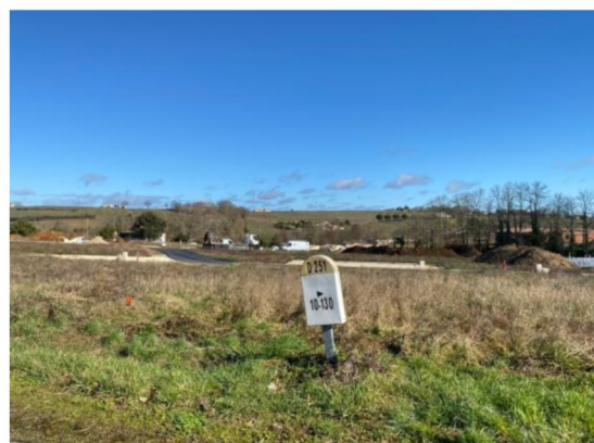
Logements en construction // Source : crédit photo MERC/AT
