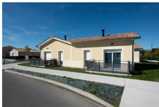
Logement de la résidence Jean Mermoz destiné à la colocation pour senior. Source : Girondehabitat.fr
